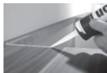
Trin 3: Påfør silikone sparsomt, cirka 5 mm fra kanten.
